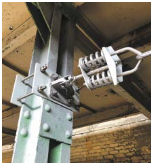
POSE DE POINT D'ANCRAGE Un point d'ancrage est une protection qui prévient des chutes en hauteur et permet de sécuriser une zone inaccessible au public (zone industrielle à risque, zone sous les toits etc.)
