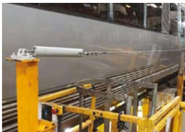
LIGNE DE VIE POUR ACCÈS À UNE PASSERELLE INFÉRIEURE D'un côté, mise en place d'une fixation (point d'extrémité) sur charpente existante. De l'autre côté, installation d'un poteau sur-mesure avec fixation par scellement chimique.
