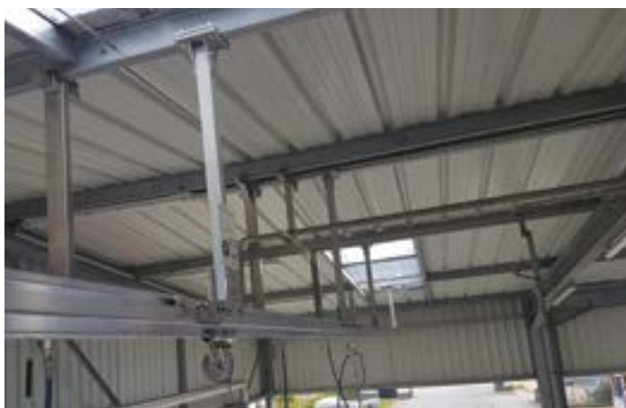
LIGNES DE VIE SUR RAIL POUR NETTOYAGE DES CITERNES Crapautage sur charpente, montage de chandelle avec adaptation de cote sur place. Rail aluminium et fixations inox.
